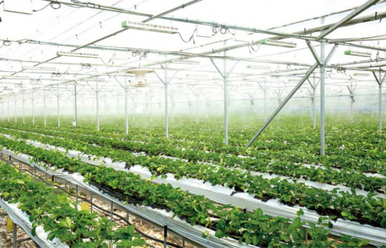
김영웅 동문의 딸기 온실. 광량과 습도, 이산화탄소, 비료, 온도 등의 환경 여건이 최적의 상태로 자동으로 조절된다. 사진은 습도 조절을 위해 상단에 설치된 급수관에서 물을 분무하는 모습.
