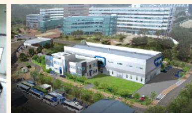
그림 5. 소단면 터널식 공동구 실험형 성능검증 시설
